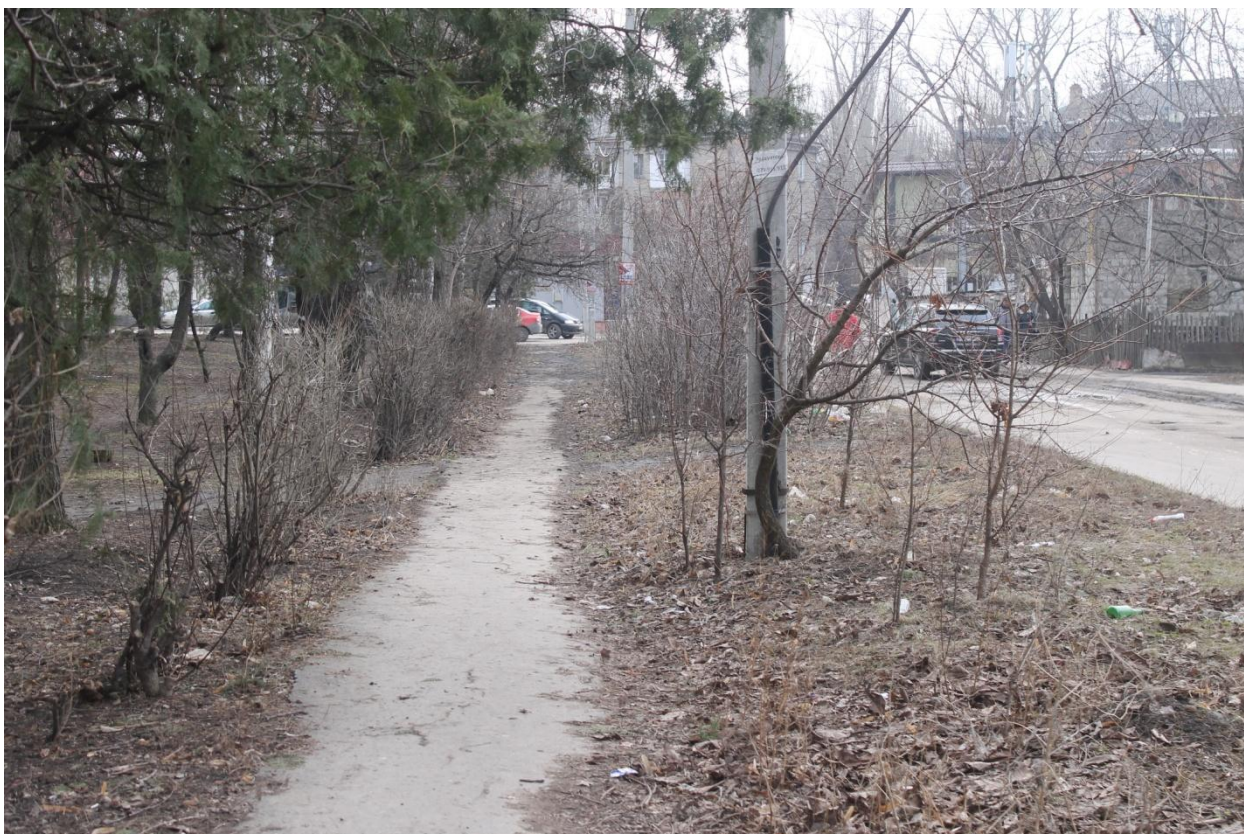
Imaginea nr. 22: Trotuar pe strada Cahul Sursa: Vizite de observare (septembrie 2018 – februarie 2019)
